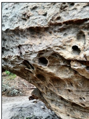
Рис. 3. Коррозионные ниши выдувания в песчаниках Каменного Города Автор фото: Красиков Д. (2020)
